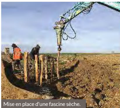
Mise en place d'une fascine sèche.
