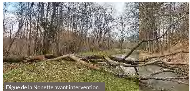
Digue de la Nonette avant intervention.
