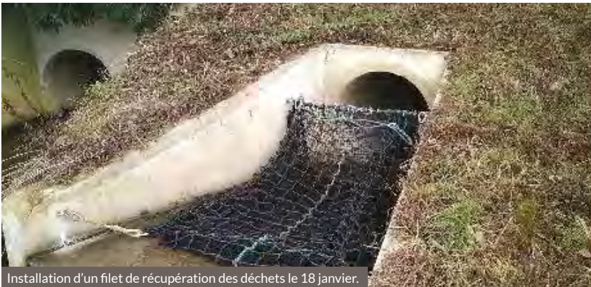
Installation d'un filet de récupération des déchets le 18 janvier.
