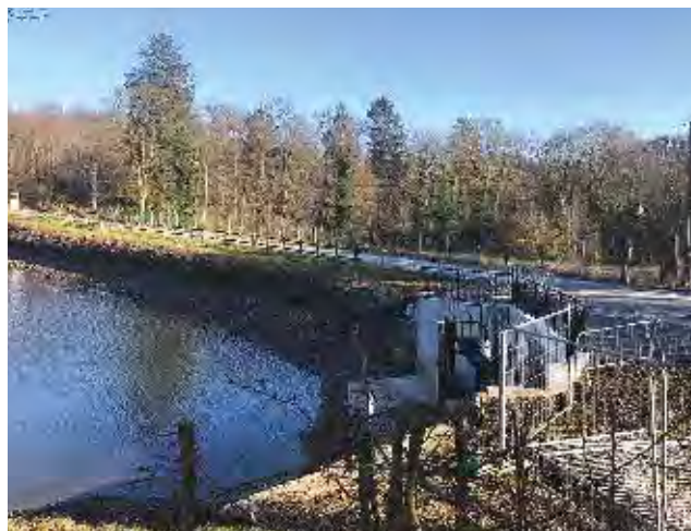
Mise en place de deux dalots.
